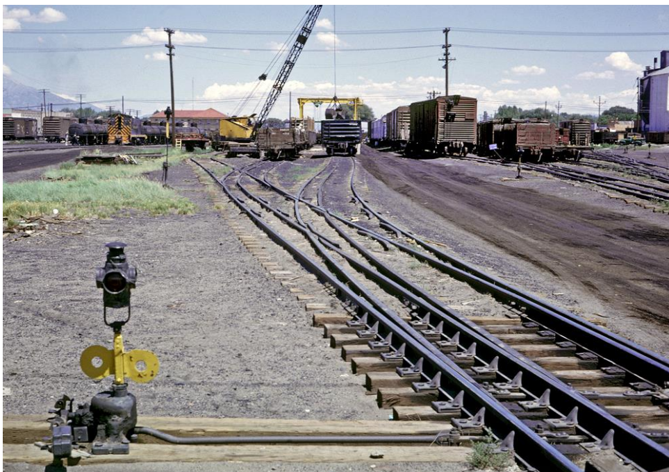
Dreischienen-Weiche und Gleissystem in Alamosa CO ca. 1960. Man beachte im Hintergrund den Umlad von Schüttgut von einer Narrow- zu einer Standard-Gauge Gondola.
